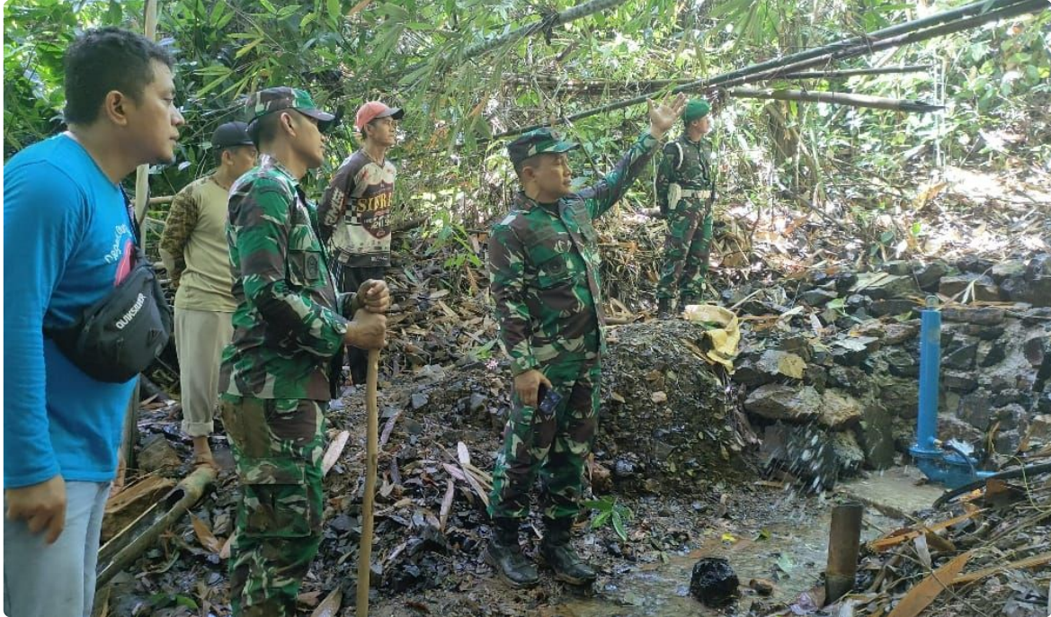
Pompa Hidram tersebut merupakan program manunggal air Kodim 1402/Polman di Kampung Arra, Desa Kelapa Dua, Kecamatan Anreapi, Polewali Mandar.
